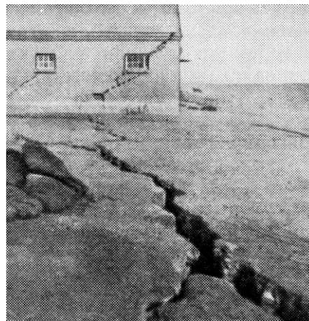
*Рис. 7.2. Трещины в грунте и повреждение здания, вызванные смещением грунта при Ляопинском землетрясении в Китае. По Дж.А.Эйби*
