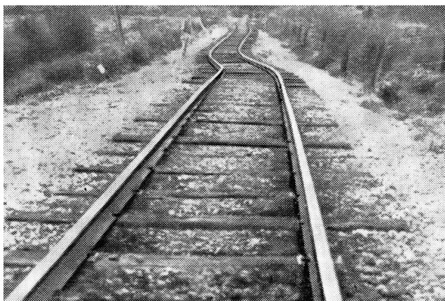
Рис. 7.3. Железная дорога, разрушенная землетрясением. По Дж.А.Эйби
