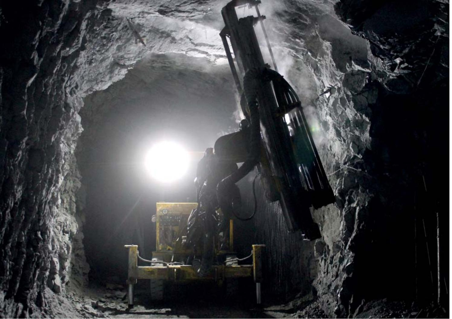
Рис. 4. Бурение шпуров при проходке автотранспортного уклона
