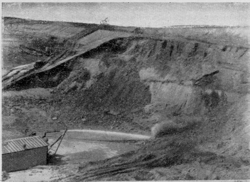
Рис. 14. Удаление пустых пород в западной части карьера размывом мониторами.
