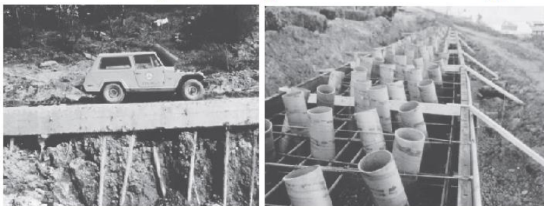
Рисунок 16.15. Корневидные сваи для контроля оползня, Монессен, Пенсильвания: (сверху) корневидные сваи – вид спереди; (внизу) корневидные сваи крупным планом. (Фото любезно предоставил доктором U. Dash, Департамент транспорта Пенсильвании.)
