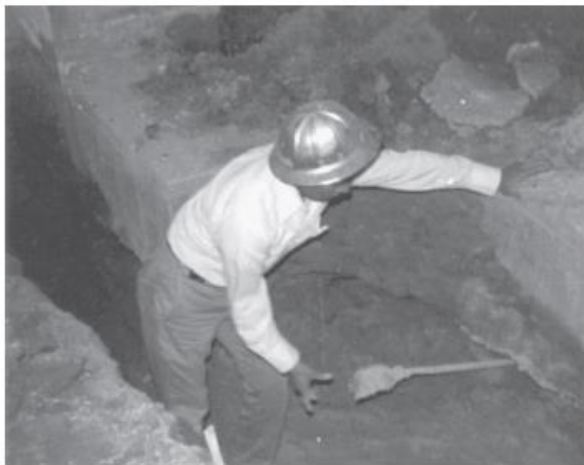
Рисунок 15.2. На фотографии показана просадка грунта на нижнем ярусе в результате землетрясения в Гватемале в 1976 году.
