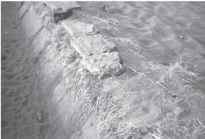
Рисунок 18.18. Солома используется для защиты открытых стоков от дрейфующего песка.
