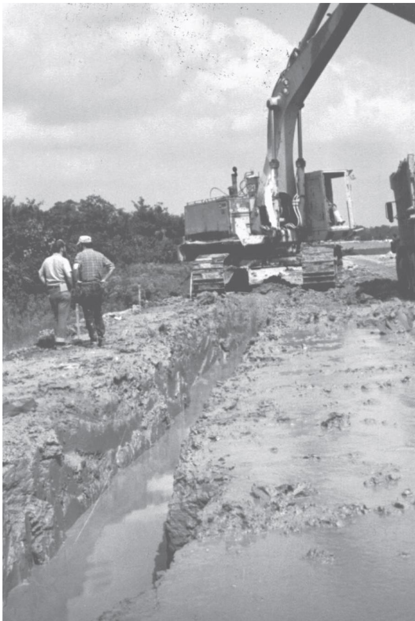
Рисунок 17.15b. Раскопки шламowego желоба: фото с изображением раскопок шламowego желоба.
