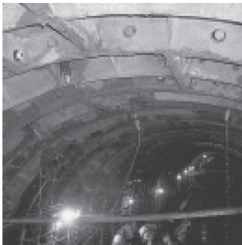
Рис. 2.13. Нагнетание глинистого раствора шлангами, присоединенными к тубингам обделки перергонного тоннеля между станциями метро «Грушевка» и «Михалово» в Минске
