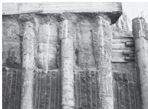
Рис. 2.21. Устройство армирующих элементов по периметру котлована для здания ОАО «Приорбанк» по пр. Победителей в Минске [35]
