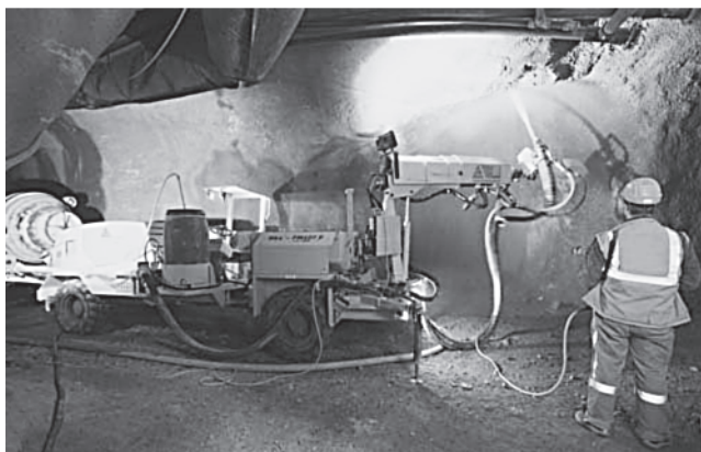
Рис. 2.2. Самоходная торкрет-установка Sika-PM 407 в тоннеле ( http://aliva.pro , 2014)
