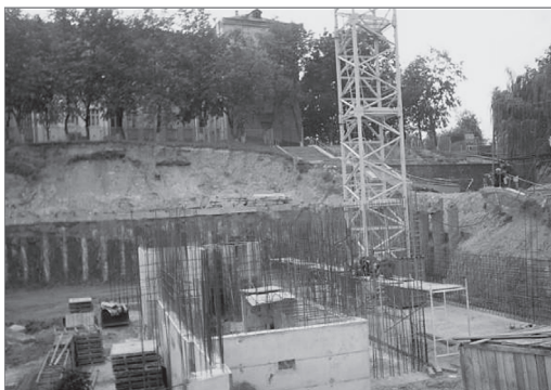
Рис. 2.21. Устройство армирующих элементов по периметру котлована для здания ОАО «Приорбанк» по пр. Победителей в Минске [35]
