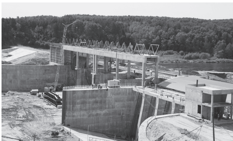
Рис. 6.5. Гродненская ГЭС на этапе строительства ( http://www.quickwiki.com , 2011)
