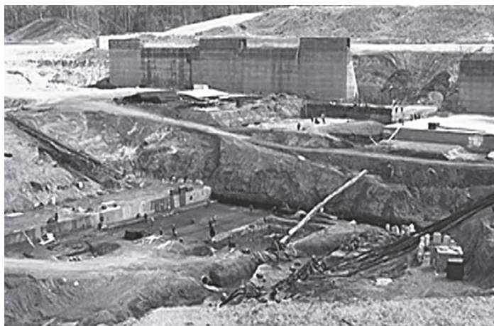
Рис. 6.4. Котлован на площадке строительства Витебской ГЭС ( http://ont.by/news , 2014)
