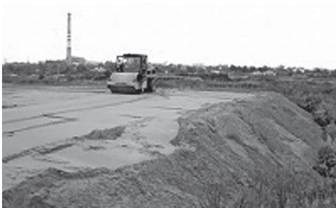
Рис. 6.1. Подготовка площадки строительства Ледового дворца с залом акробатики в Барановичах [75]
