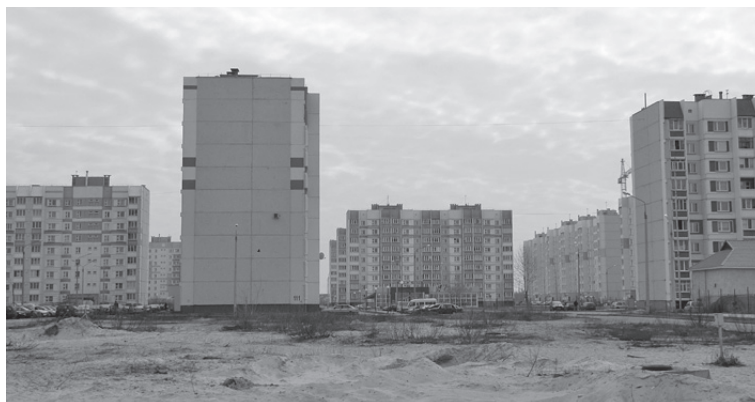
Рис. 3.10. Строительство многоэтажных жилых домов на намывных песках в микрорайоне «Мельников луг» Гомеля [26]
