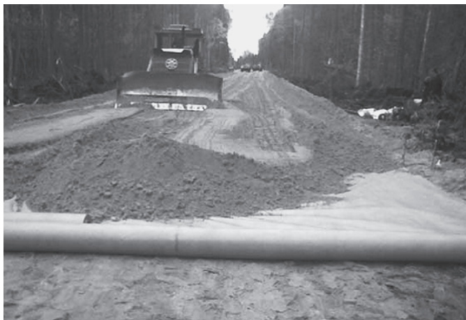
Рис. 6.6. Строительство дороги с использованием геосинтетического материала в Быховском районе Могилевской области
