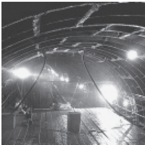
Рис. 2.13. Нагнетание глинистого раствора шлангами, присоединенными к тубингам обделки перергонного тоннеля между станциями метро «Грушевка» и «Михалово» в Минске
