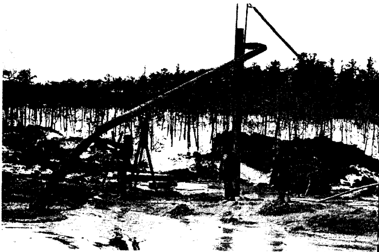
Рис. 1.25 Сквaziнная гидродобыча песков в болотах Тюмени
