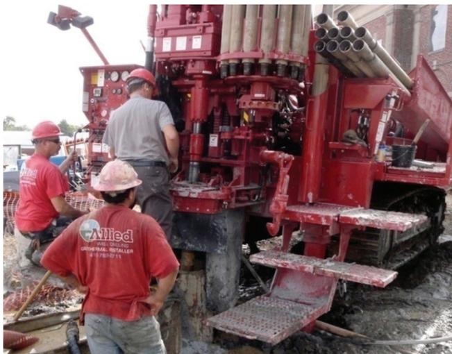
Рис. 4.26. Процесс бурения агрегатом Schramm T450GT
