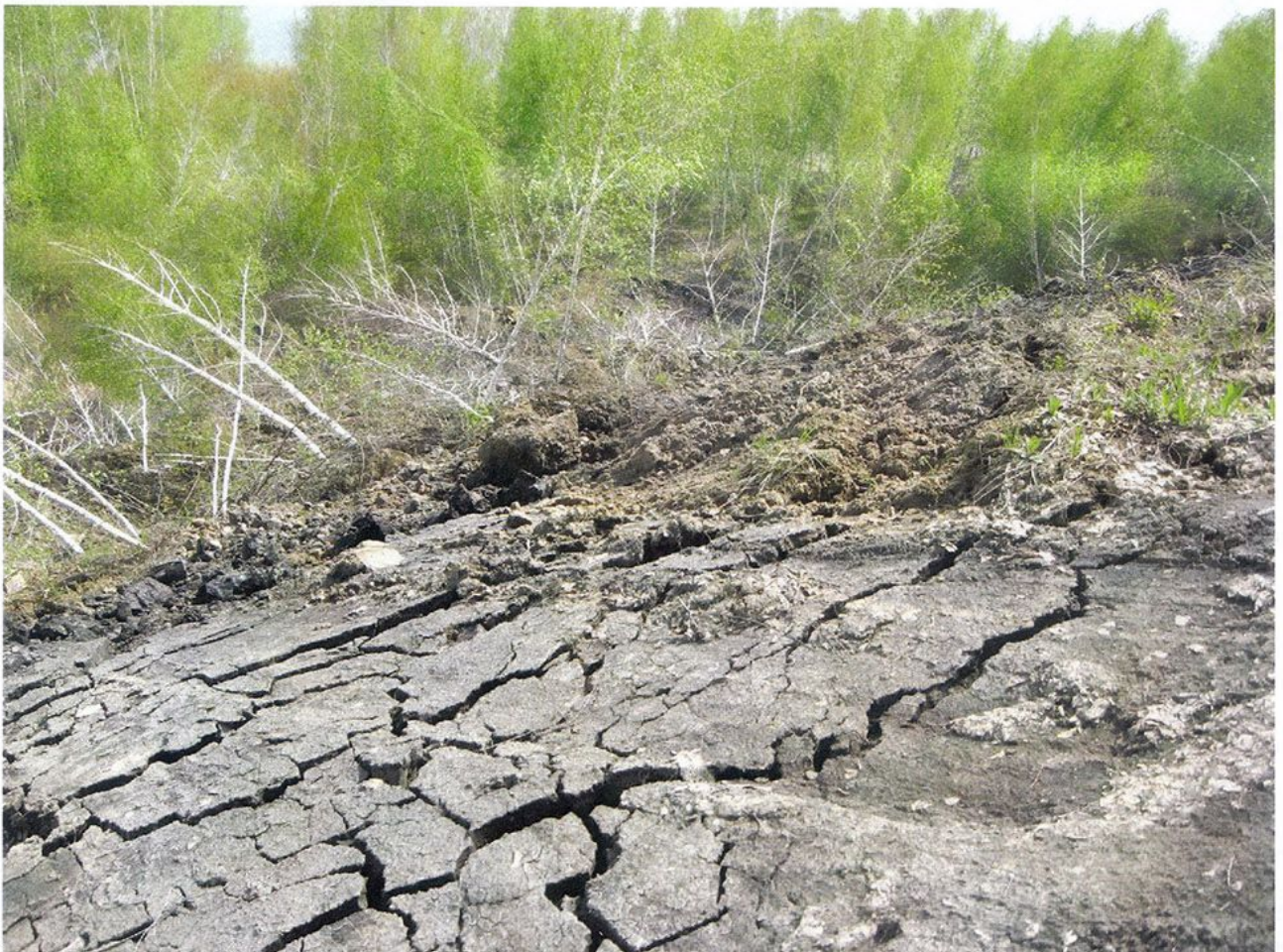
Рис. 10. Оползневые деформации глинистой пачки апта
