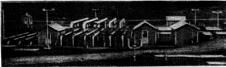
Рис. XVIII. 9. Пункт централизованного измерения расхода газа в подземном хранилище.
