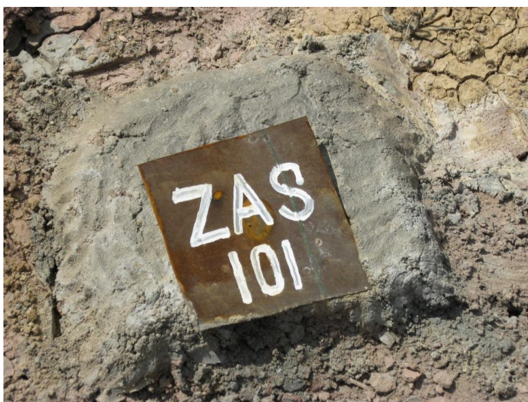
Рис. 1.3 - Пример консервации буровой скважины
