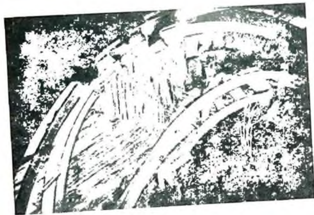
Рис. 46. Характер деформации пород и крепи в откаточном штреке пласта m_1 (шахта им. К. И. Гаевского)
