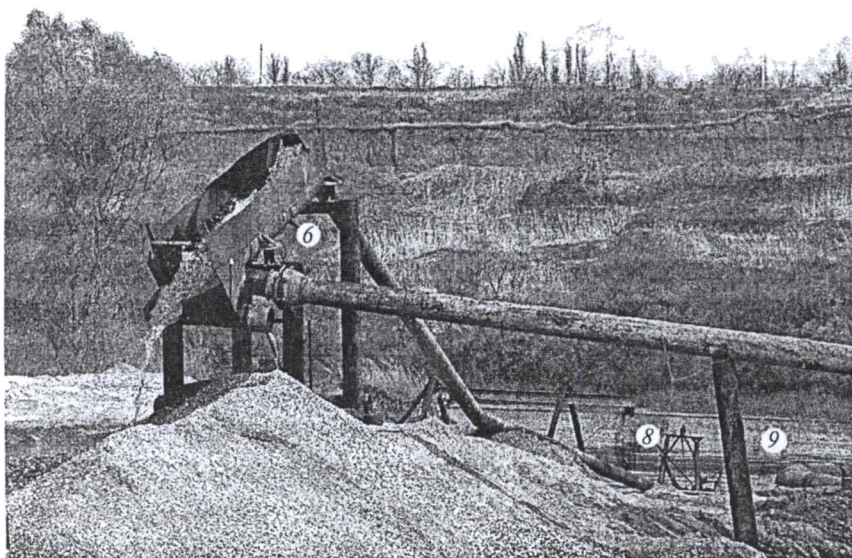
Рис. 6.6. Установка переработки песчано-гравийной смеси конструкции ЗАО «Донтрансгидромеханизация»:
