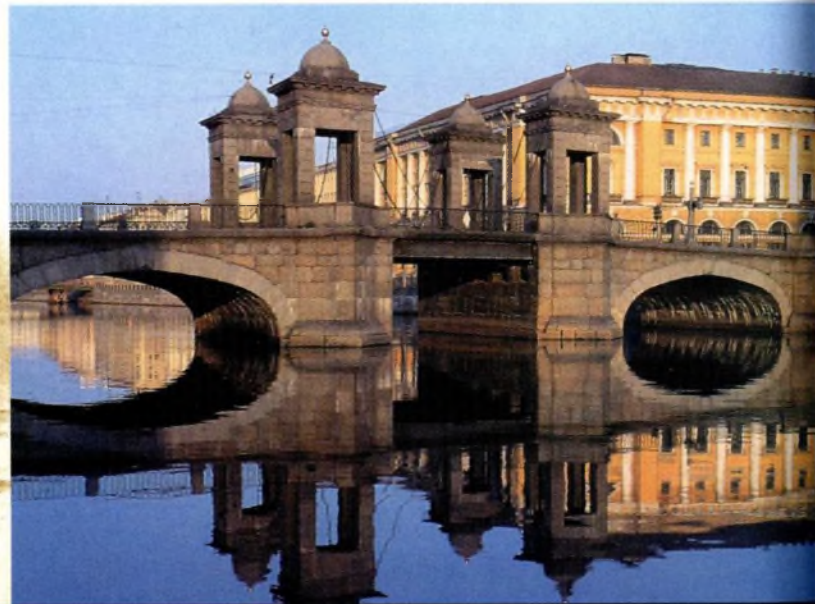
Мост Чернышова. 1784—1788 гг. Санкт-Петербург Chernyshov Bridge. 1784—1788. St. Petersburg.
