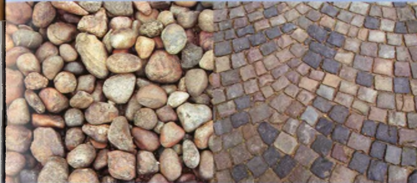
Брусчатка дорожного покрытия — ропручейский габбродиабаз, шокшинский кварцит. Петрозаводск Cobblestone road, Ropruchei gabbro-diabase and Shoksha quartzite. Petrozavodsk
