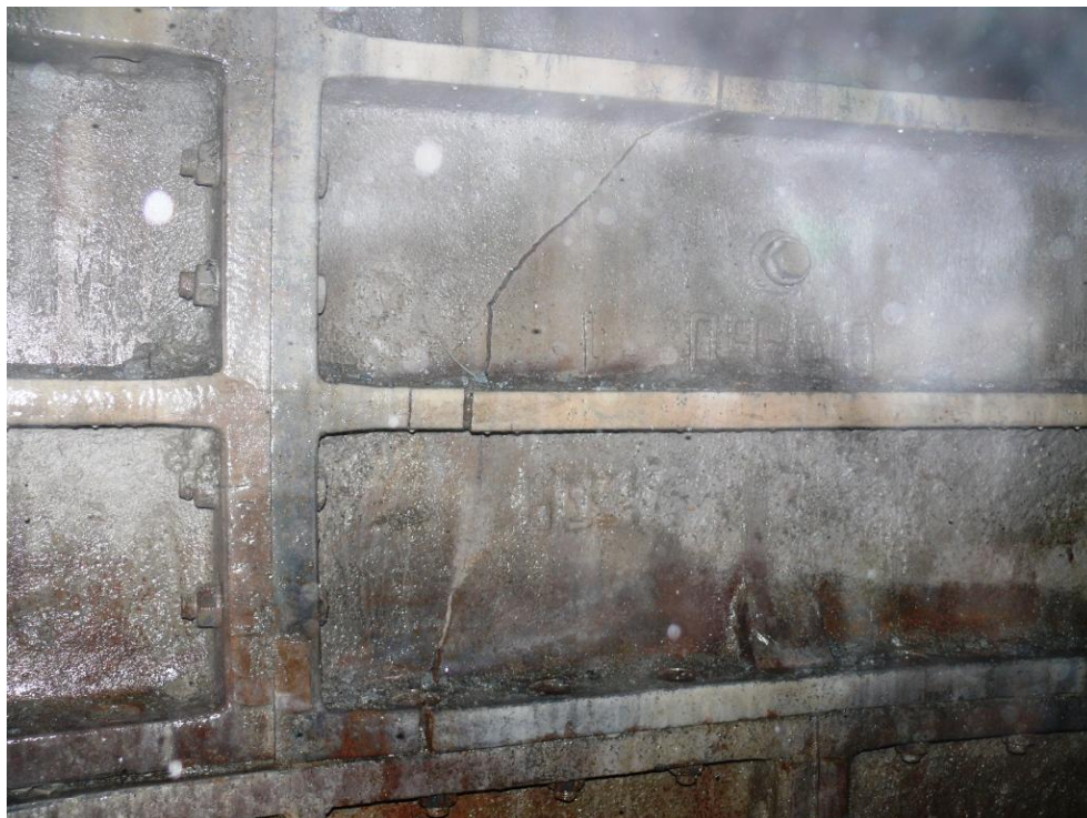
Рисунок 1.6 – Раскол тубинга в кольце №30 ствола «Вентиляционный» в районе сопряжения гор. отм. -560 м
