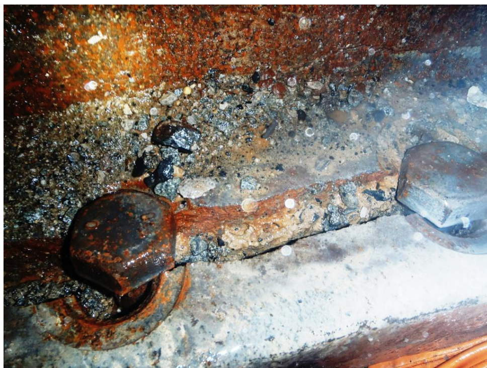
Рисунок 1.6 – Раскол тубинга в кольце №30 ствола «Вентиляционный» в районе сопряжения гор. отм. -560 м
