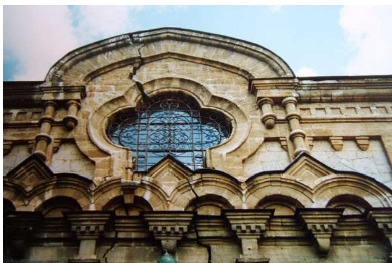
Рисунок 4.16 – Фрагмент проявления трещин
