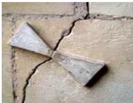
Рисунок 4.4 – Схема закрепления гипсовых маяков
