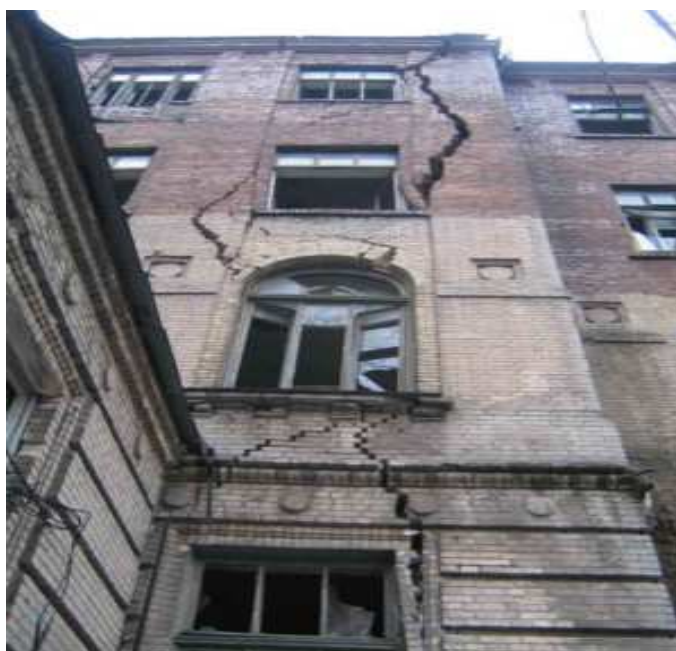
Рисунок 4.16 – Фрагмент проявления трещин
