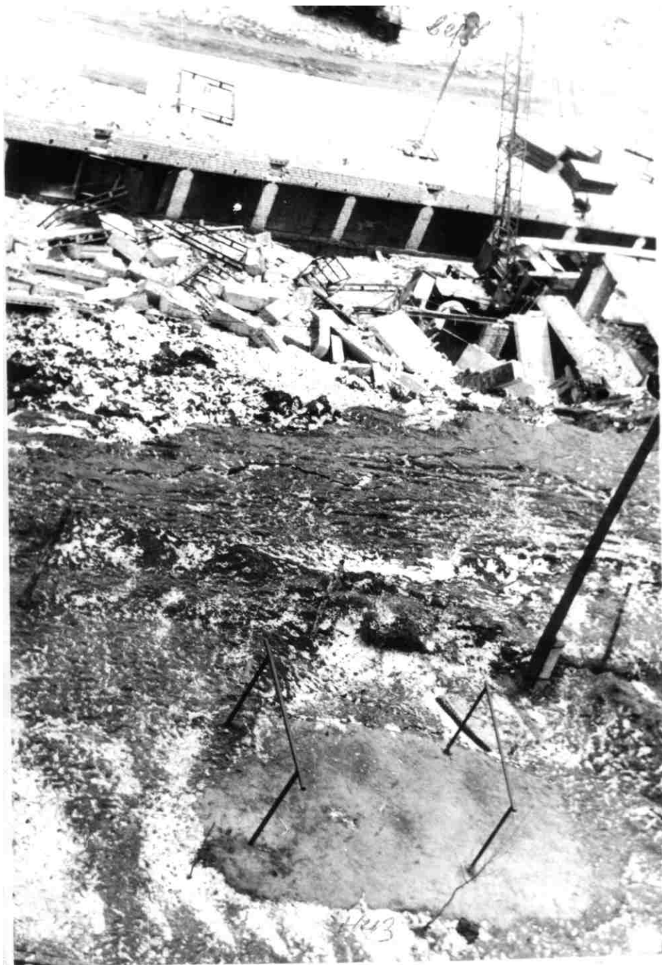
Рис. 25. Разрушенный антропогенным оползнем 3-х этажный гараж по ул.Кавалерийской, 5а. 1988 г.
