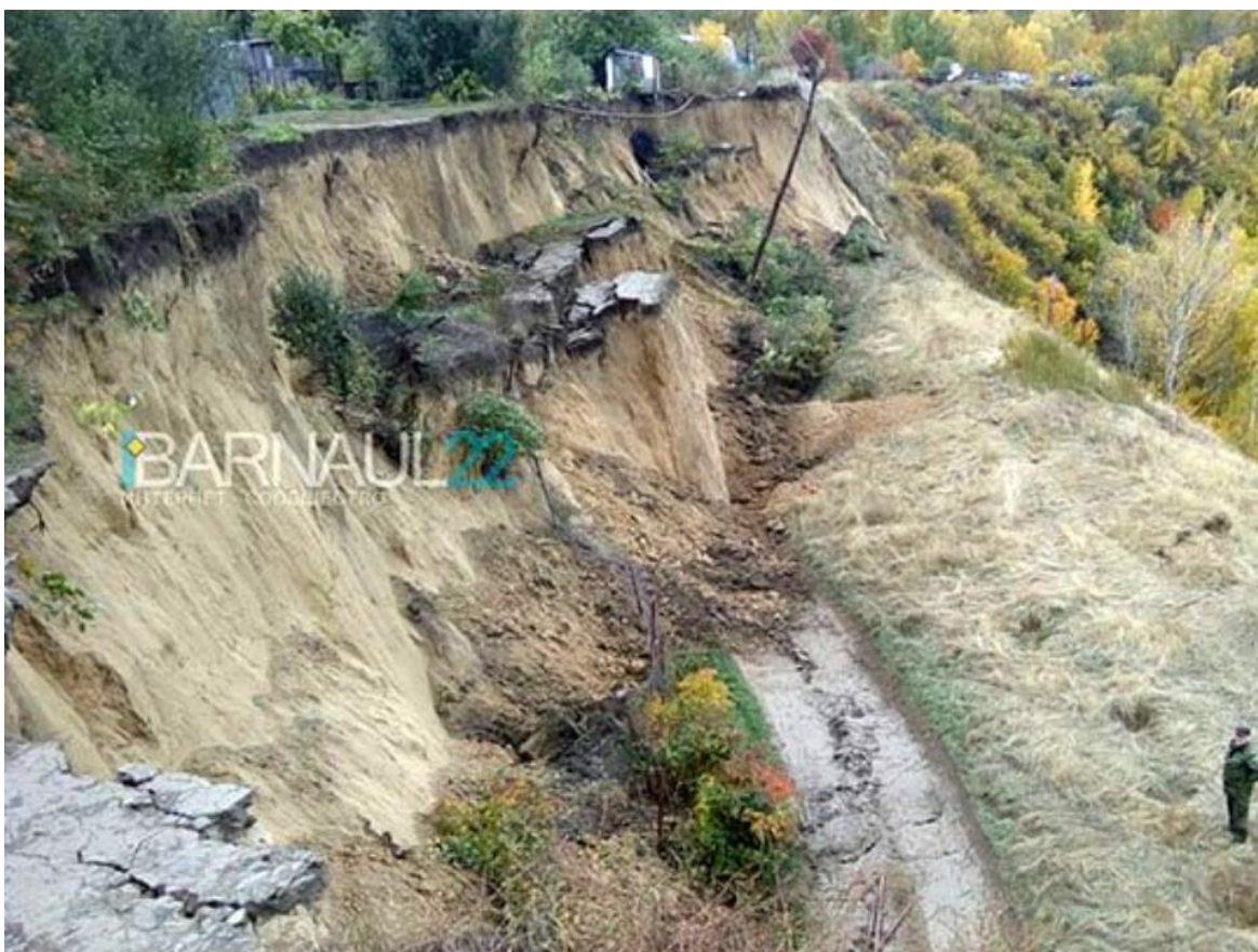
Рис. 22. Оползень сдвига на склоне долины р. Оби в садоводстве Обь г. Барнаула. В верхней части обнажения под почвенным слоем лёссы
