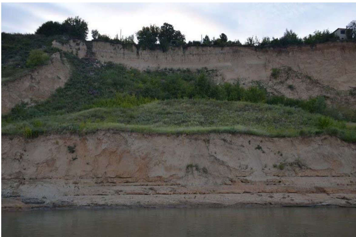
Рис. 23. Оползневой цирк на склоне Приобского плато. В верхней части обнажения лёссы
