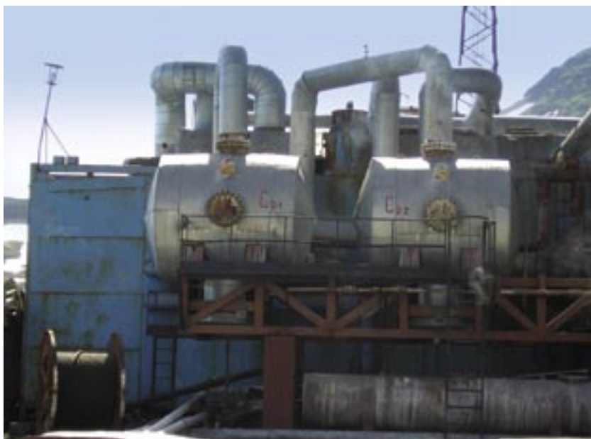
Рис. 1.2 г. Сепараторы 2-ой линии Верхне-Мутновской ГеоЭС
