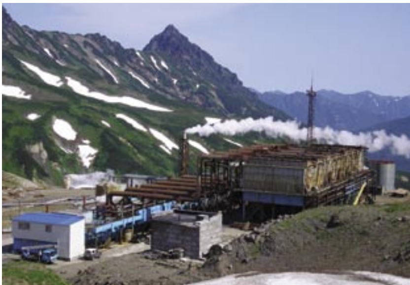
Рис. 1.2 б. Верхне-Мутновская геотермальная электрическая станция
