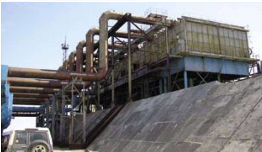
Рис. 1.2 в. Система конденсации пара Верхне-Мутновской ГеоЭС
