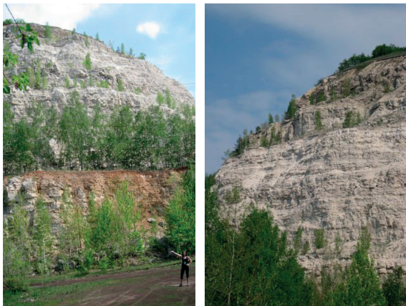
Рис. 13. Карьер на горе Тип-Тяв Красноглинского района г.о. Самара: слева – частичная рекультивация нижних уступов; справа – отсутствует рекультивация на верхних уступах
