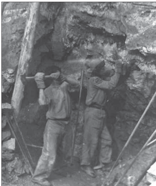
Месторождение Свободное. Проходка шпуров в забое карьера вручную. 1950 г.
