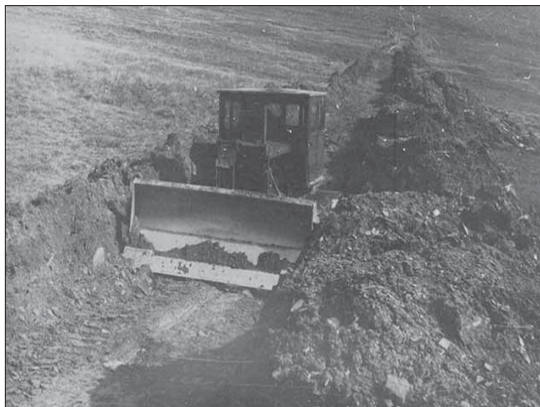
Месторождение Додо. проходка горных выработок с помощью бульдозера. 1961 г.
