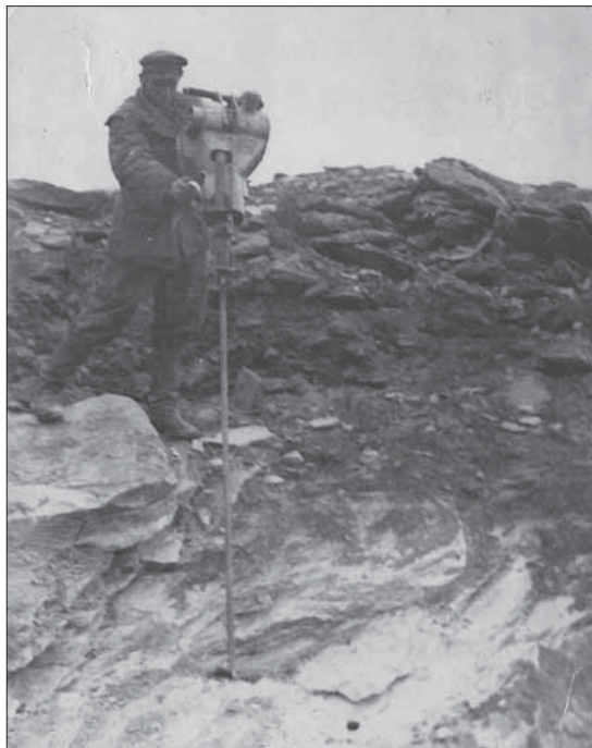
Бурение шпуров на месторождении Зейка. 1954 г.
