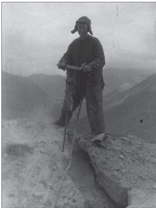
Бурение шпуров на месторождении Додо. 1956 г.
