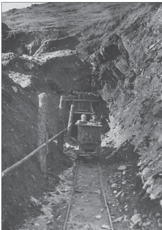
Месторождение Зейка. Откатка породы из штольни вручную. 1958 г.
