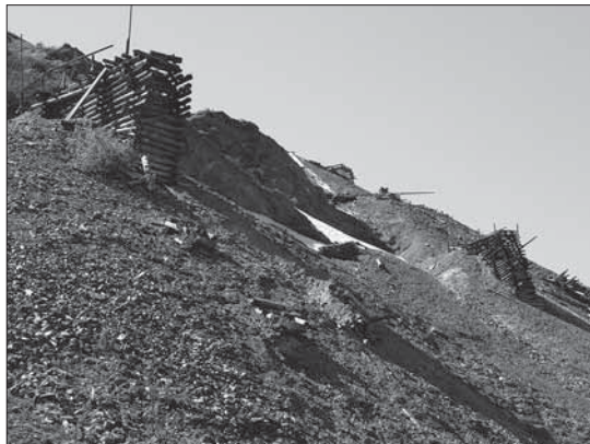
Вид на эстакады штолен месторождения Пуйва. 2012 г.
