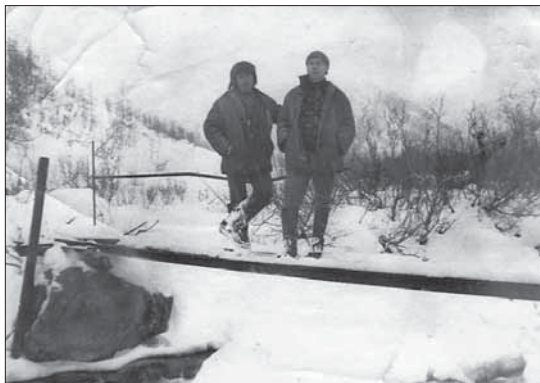
Пос. Пуйва. Мостик через руч. Жильный. 1975 г.
