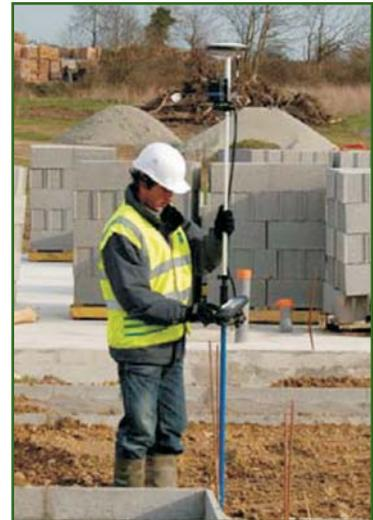
налов глобальной навигационной спутниковой системы GPS и широкозонной системы дифференциальной спутниковой навигации SBAS для ускорения инициализации, надежности и обеспечения сантиметровой точности. Это делает ProMark3 RTK базовой платформой для развития приемников будущих поколений.
