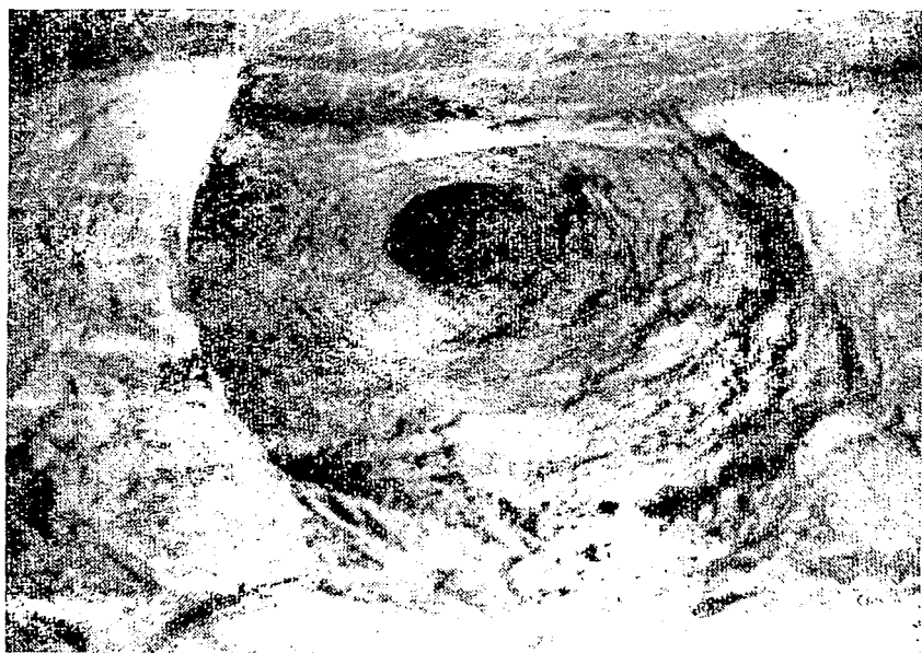
Рис. 23. Полость, образованная в результате выброса соли и газа из стенки камеры
