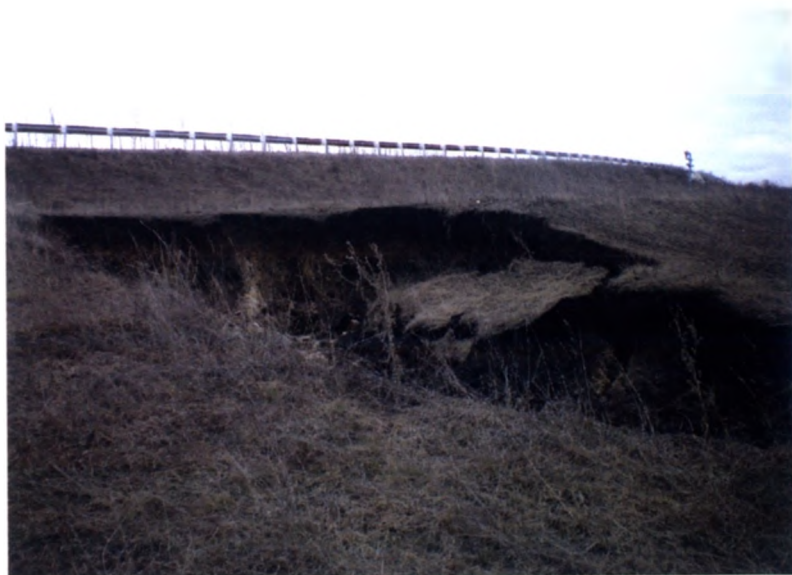
Фиг. 26. Взаимодействие элементов эрозийной сети с дорожной сетью. Окрестности с. Садовка Балтайского района Саратовской области
