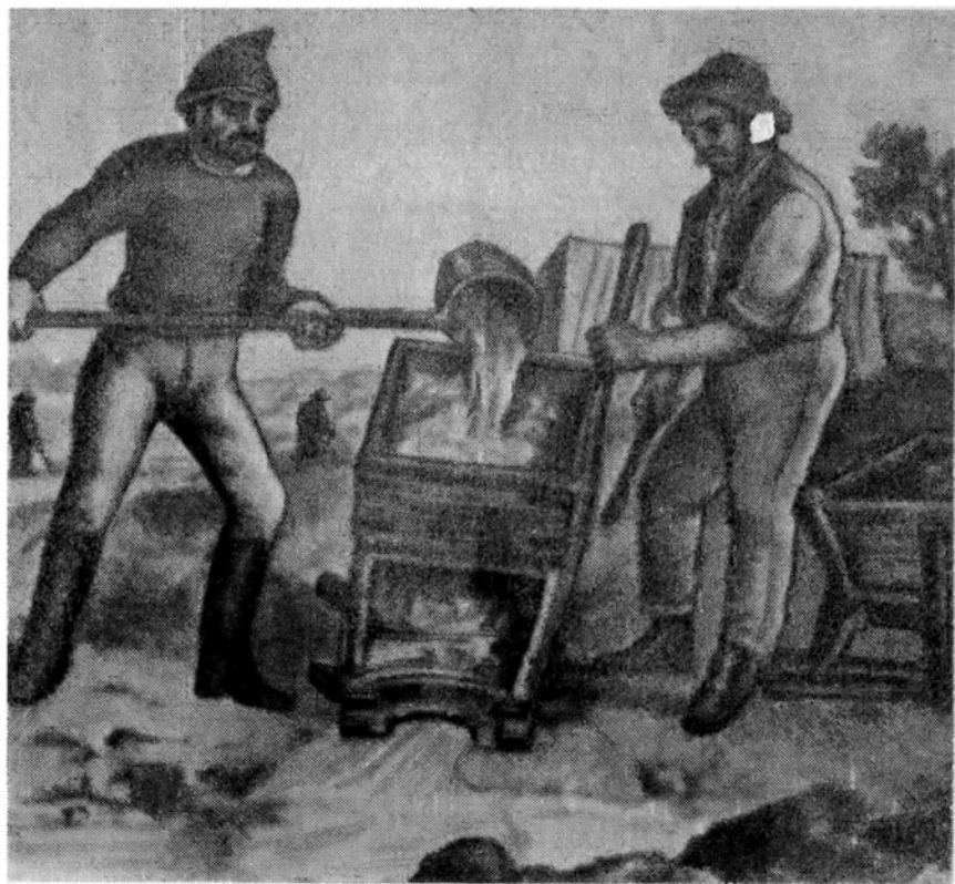
Рис. 19. Ручная промывка золотосодержащих песков на коротком шлюзе в середине XIX века [фотография с австралийской гравюры]
