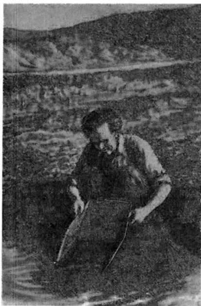
Рис. 20. Промывка пробы, взятой из россыпи, в лотке. Лоток деревянный сибирского типа [Хрипков А.В. Как искать золото. Магадан, 1959]
