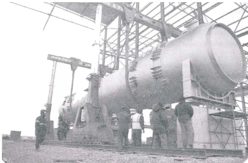
Рисунок 9.4. Монтаж автоклава
