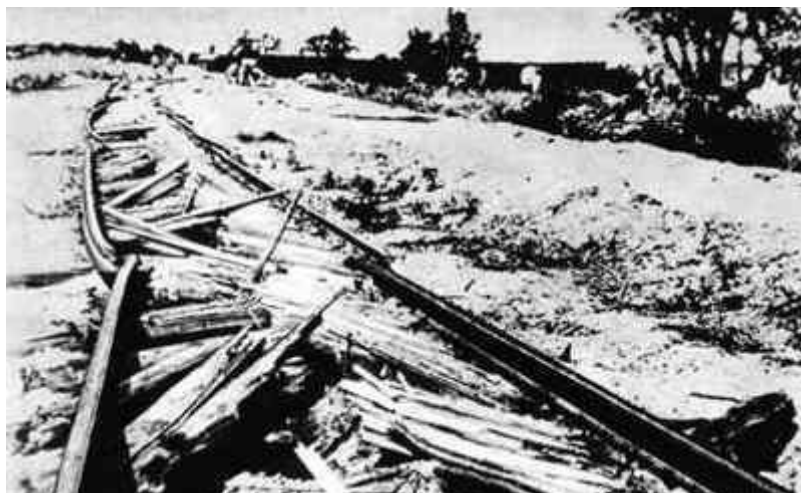
Рис. 3.16. Разрушенный железнодорожный путь под воздействием землетрясения
