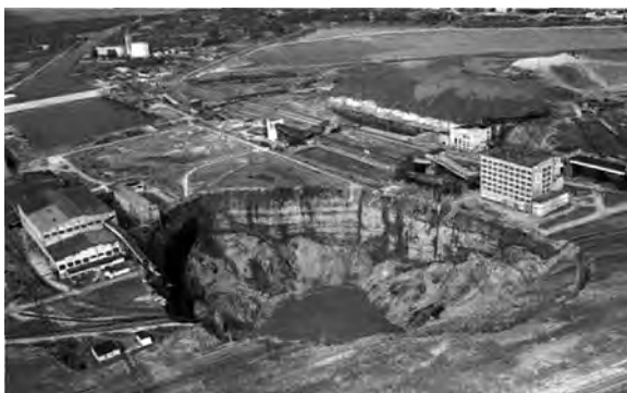
Рис. 1. Провал земной поверхности в г. Березники, произошедший в 2006 г. (фото 2008 г.)
