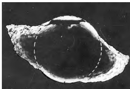
Рис. 3.3. Типичная форма сечения вертикальной выработки (рудоспуска) в условиях неравнокомпонентного поля напряжений (рудник «Центральный» ОАО «Апатит», Кольский полуостров)
