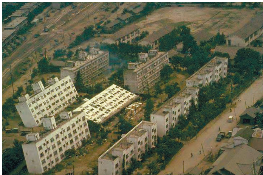
Рис. 2.3. Эффекты разжижения грунтов при землетрясении (USGS)
