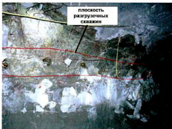
Рисунок 1 – Нарушение крепи выработки на участке бурения разгрузочных скважин
