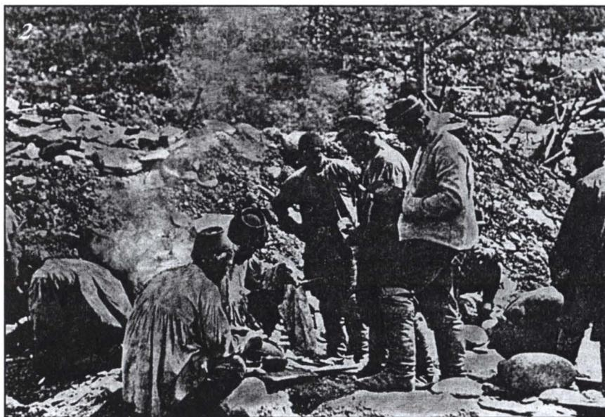
**Рис. 13.** Артельки «вольных старателей-хищников» в таежных дебрях Восточной Сибири на разработке золотоносной россыпи, «ямами» с промывкой песков ручными лотками (вверху) и за дележом намытого золота (внизу). Начало XX столетия
