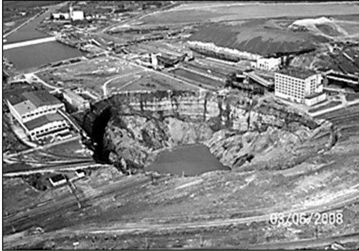
Рис. 2.2. Верхнекамское месторождение солей. Провал над затопленной шахтой БКРУ-1
