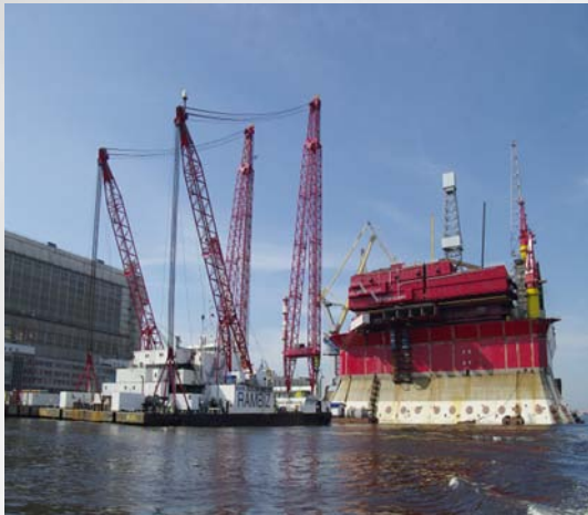
Строительство в Северодвинске
