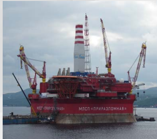
Достройка и балластировка бетоном в Мурманске
