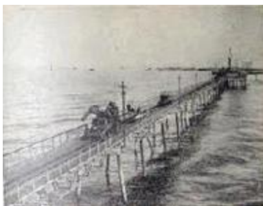
Рис. 2.3.10. Автомобильная дорога на эстакаде, ведущая к нефтепромыслам в Каспийском море в районе Баку.
