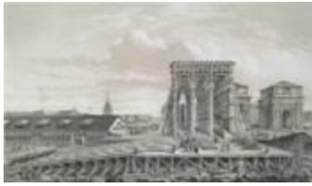
Рис. 1.1.10. Установка колонн Исаакиевского собора. Рисунок О. Монферрана
