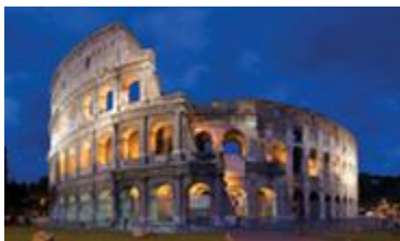
Рис. 1.1.15. Колизей. Символ римской цивилизации. Построен из бетона; мрамор использовался лишь как облицовочный материал. Colosseum – Wikipedia
