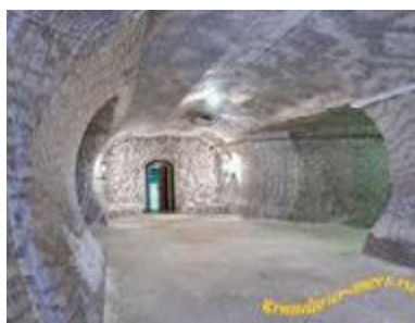
Рис. 1.2.6. Артемовское месторождение. Выработки, пройденные в сплошном соляном пласте.
