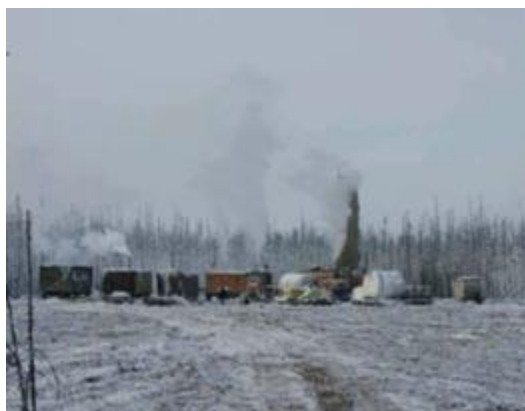
Рис. 2.1.15. Томтор. Эпоха разведки. Трактора волокут буровые и балки буровых бригад на точки бурения. Фото из архива А. В. Толстова.
